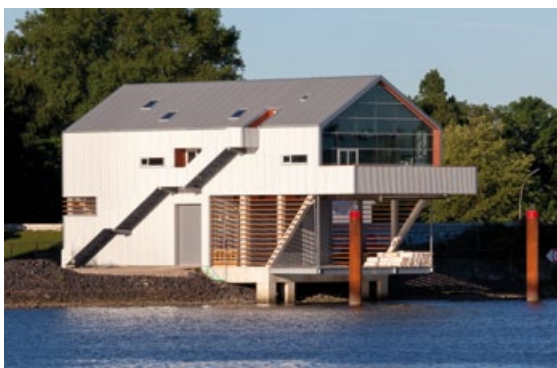
Die Mücke – von außen bereits zu bewundern, derzeit läuft der Innenausbau
